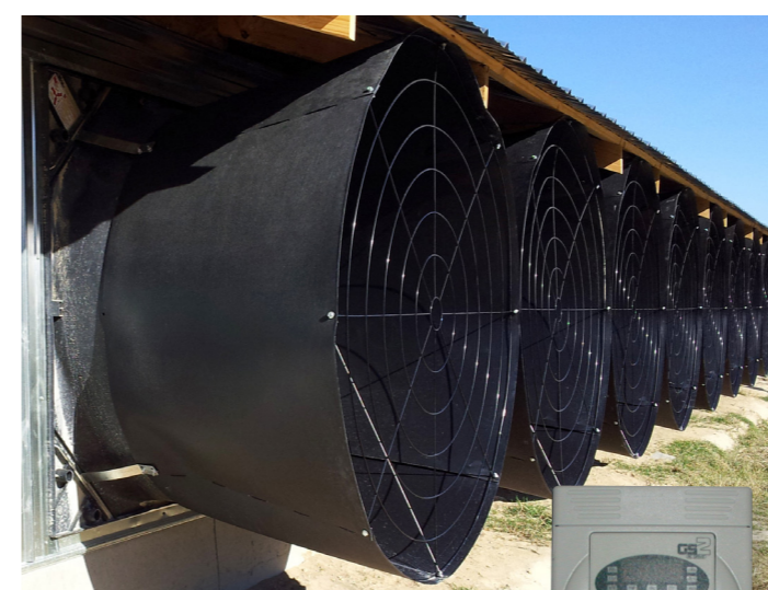
Propulsor de frecuencia variable CHORE-TIME®
