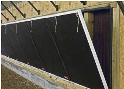
Puertas de túnel
